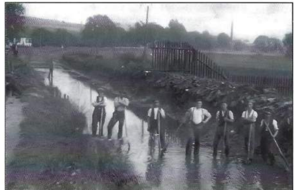
Ausräumen des Obergrabens der Firma Eichelberg auf Höhe der Schleifmühle, um 1920. [14]
